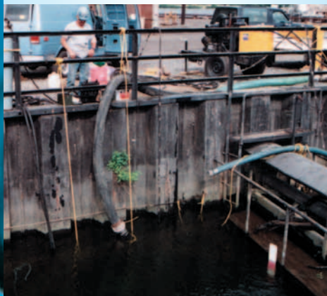
Откачка сточных вод и нечистот
