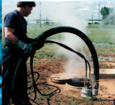
Откачка жидкости из канализационных люков
