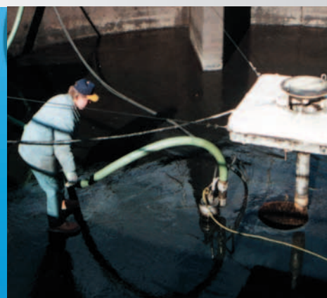
Откачка донного остатка из нефтехранилищ и цистерн
